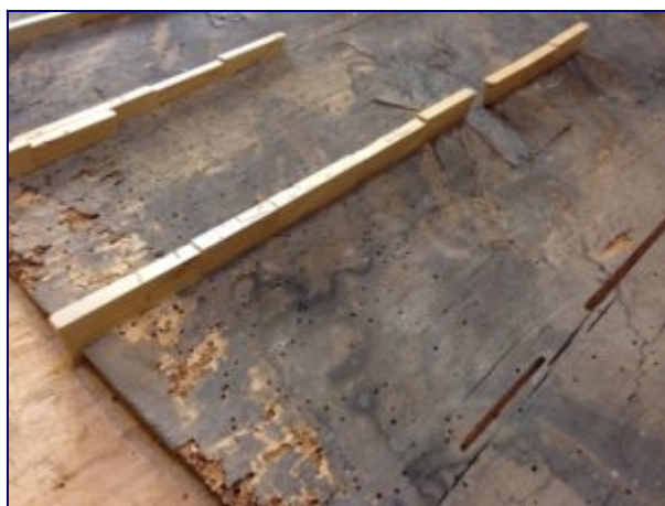
Fig. 11. Supporto ligneo, risanamento (particolare)
